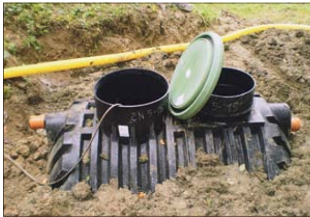
Mala čistilna naprava ob vgradnji
