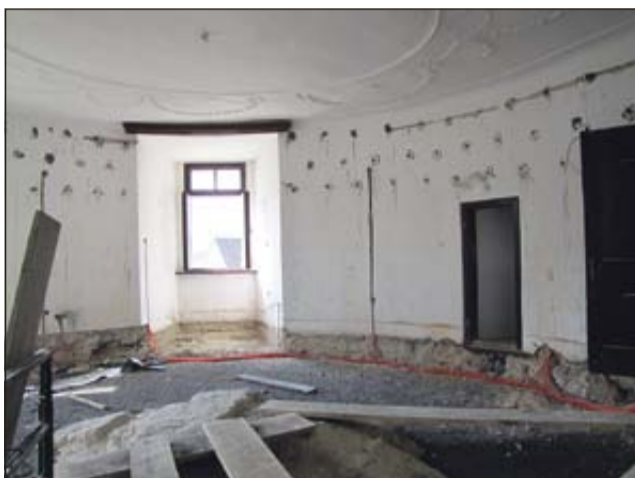
Sanacija notranjosti gradu
