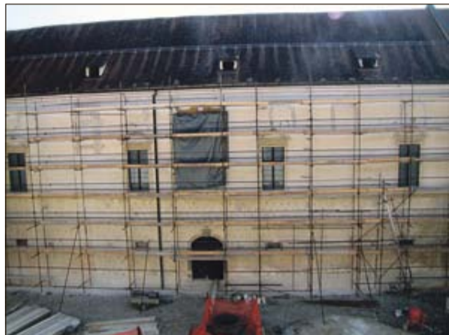
Med sanacijo odkrite okenske odprtine
