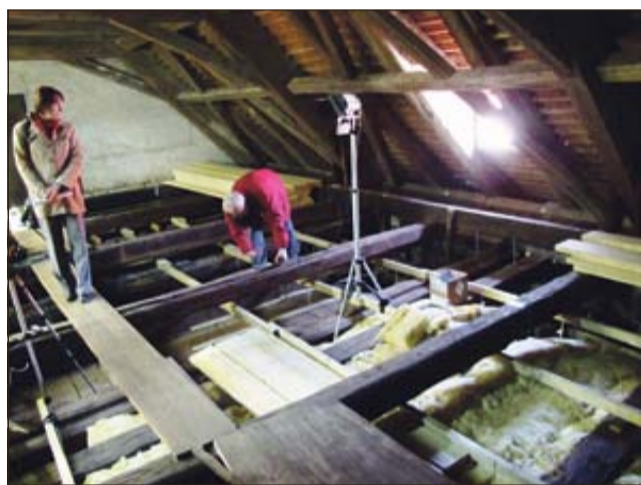
Popravila na podstrešju gradu
