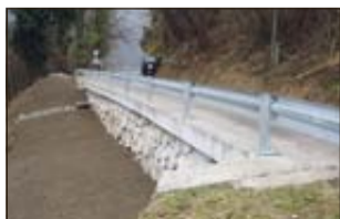
Sanacija na Jelovem
