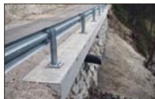
Sanacija na Vetrnem Vrh
