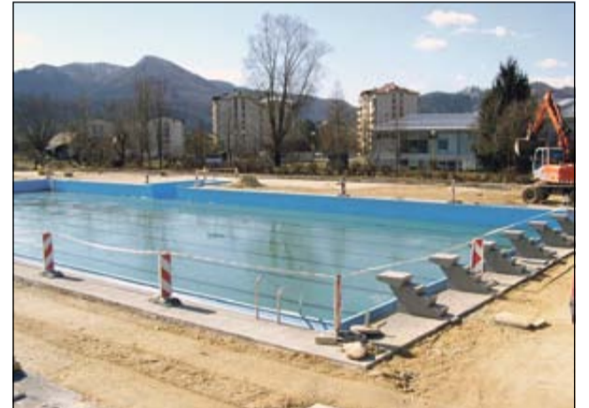
Obnovitvena dela na sevniškem bazenu naj bi bila zaključena do konca tega meseca.
