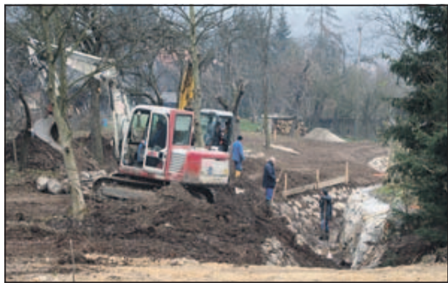
Sanacija brežin Prapreškega potoka
