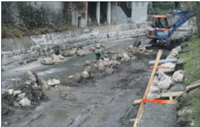
Sanacija brežin Sopote
