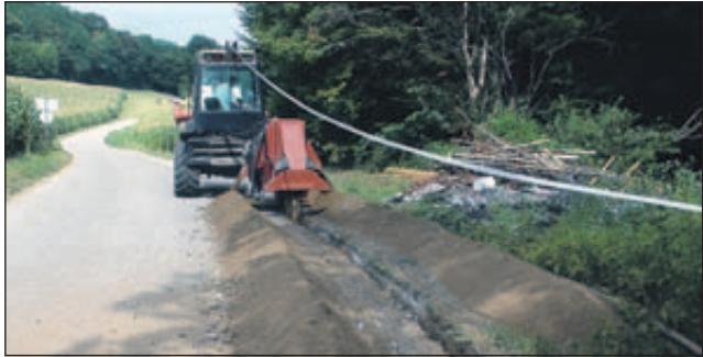
Takole so z gradnjo omrežja pričeli na območju KS Studenec. (Foto: arhiv Občine Sevnica)
