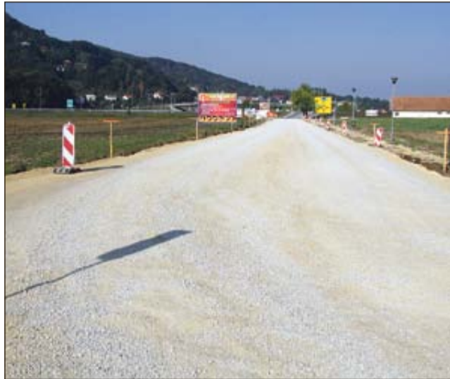
Sanacija LC Čatež Terme odsek A 2
