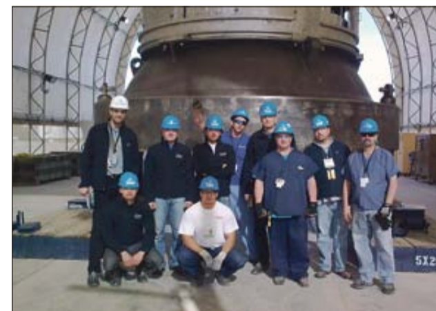
Zamenjava reaktorske glave v NE Palo Verde (Arizona, ZDA)
