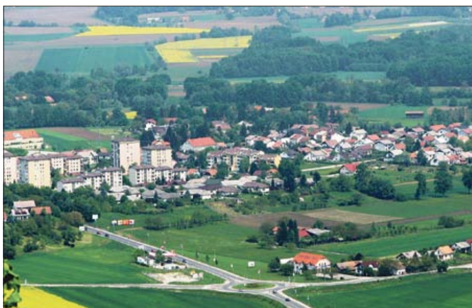
Izgradnja sekundarne kanalizacije - naložba v ohranjanje čistega okolja
