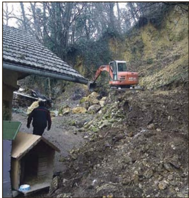
Interventni sanacijski ukrepi na grajskem pobočju (Vir: foto arhiv Občine)
