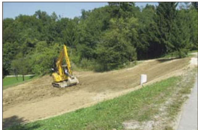
Potek sanacije plazov na Čanju (Foto: Občina Sevnica)
