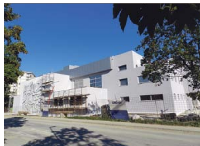
Gradnja športne dvorane pri OŠ Brežice (foto: S. M.)
