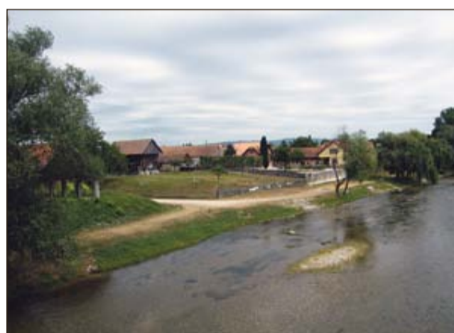
Na levi strani Krke bodo ob izgradnji HE Brežice zgradili protipoplavni zid.
