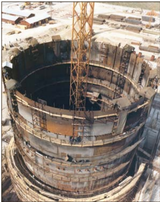
Izgradnja Jedrske elektrarne Krško (Foto: arhiv Zavoda Neviodunum)
