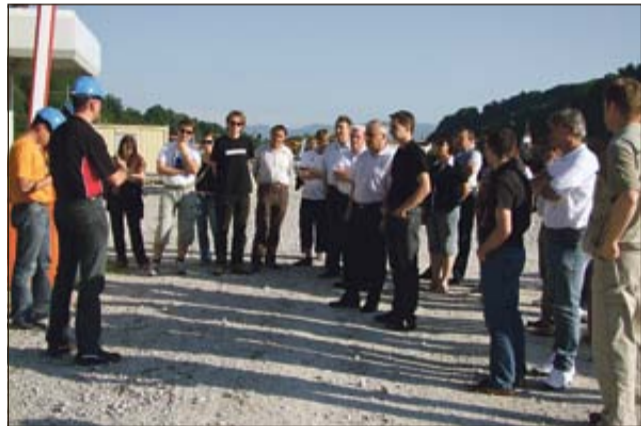
Na ogledu gradbišča HE Krško
