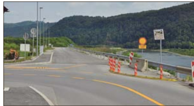
Odprt gradbiščni priključek na Blanci.
