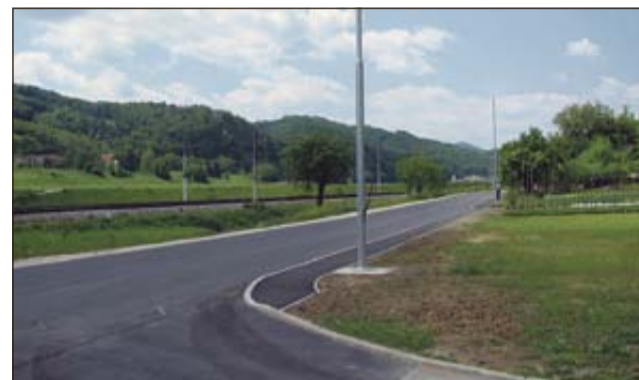
Ureditev pločnikov in spremljevalne infrastrukture v zaključni fazi. (Foto: Občina Sevnica)
